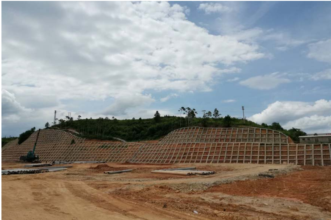
项目北侧（山体）
