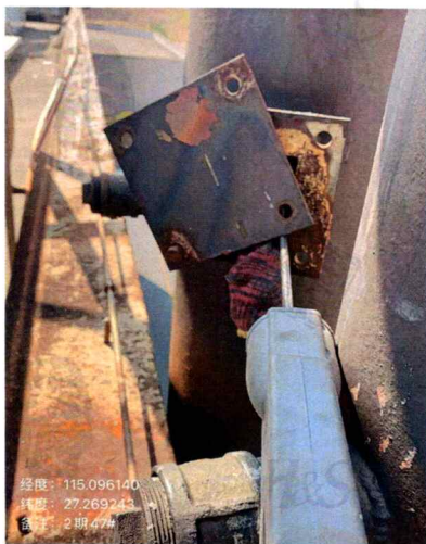
2-47#二期厂房压合车间(2#)废气排放口
