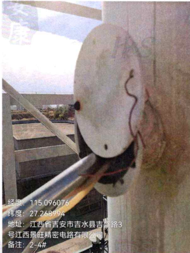
2-4#内层蚀刻、棕化、化银废气排放口
