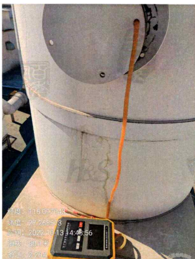
2-26#防焊喷涂、搅油房/制网房环境抽风废气排放口
