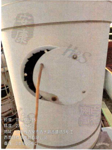
2-20#外层蚀刻线(显影/退膜段)废气排放口
