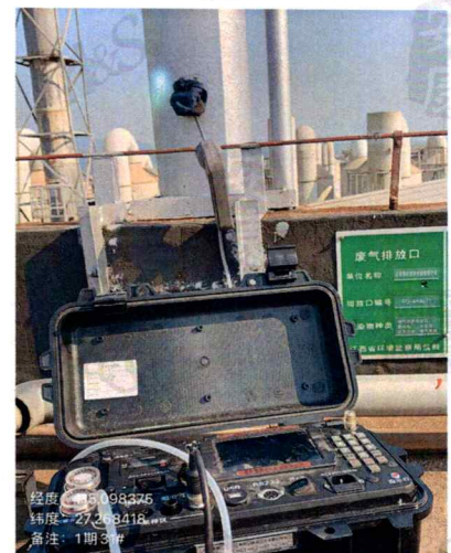
1-31#一期厂房生活热水废气排放口
