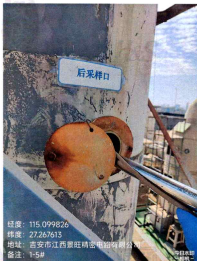
1-5#蚀刻退膜段、蚀刻段、干膜显影废气排放口
