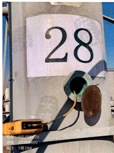
1-28#防焊印刷、喷涂废气排放口
