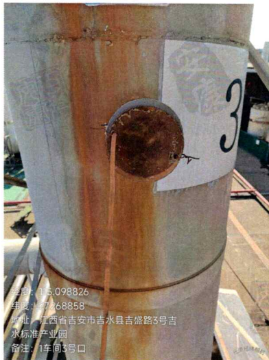
1-3#阻焊印刷、喷涂废气排放口
