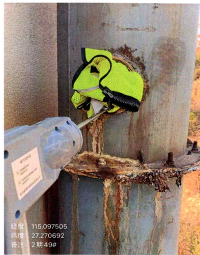
2-49#废液回收车间废气排放口
