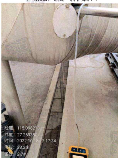
2-7#压机热抽风废气排放口
