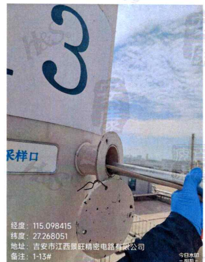
1-13#防焊显影后 16 仓烤炉 1 废气排放口
